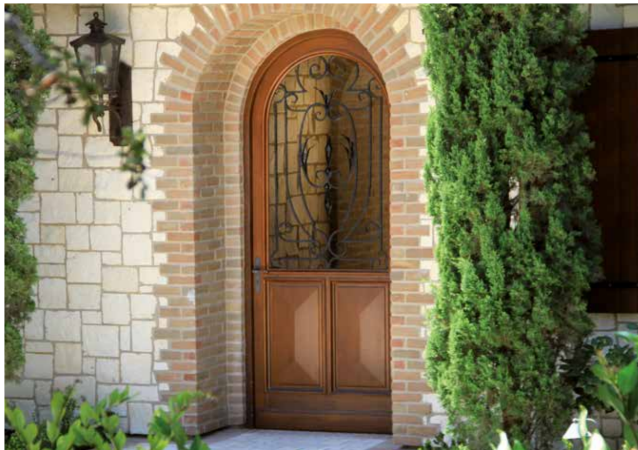
Ref. Z16 - Remontage de la grille en fer forgé d'origine.
